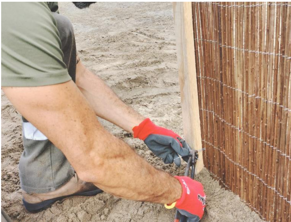
Imagen nº 10: Atado del mimbre a la primera estaca con alambre. Fuente: Gesplan S.A.
