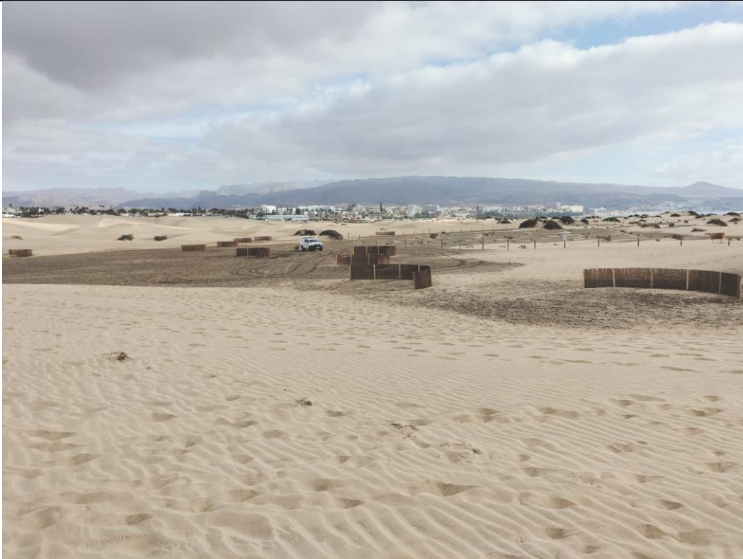
Imagen nº 11: Vista a ras de suelo de varios captadores de arena ya instalados. Fuente: Gesplan S.L
