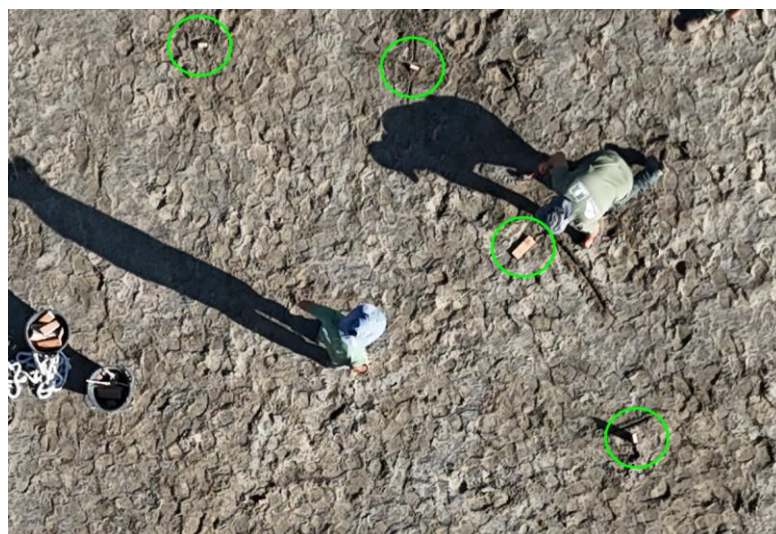
Imagen nº 5: Instalación de las pequeñas estacas para replantear los puntos en los cuales se colocarán las estacas largas. Fuente imagen cenital: Viera, M. (2-9-2024)
