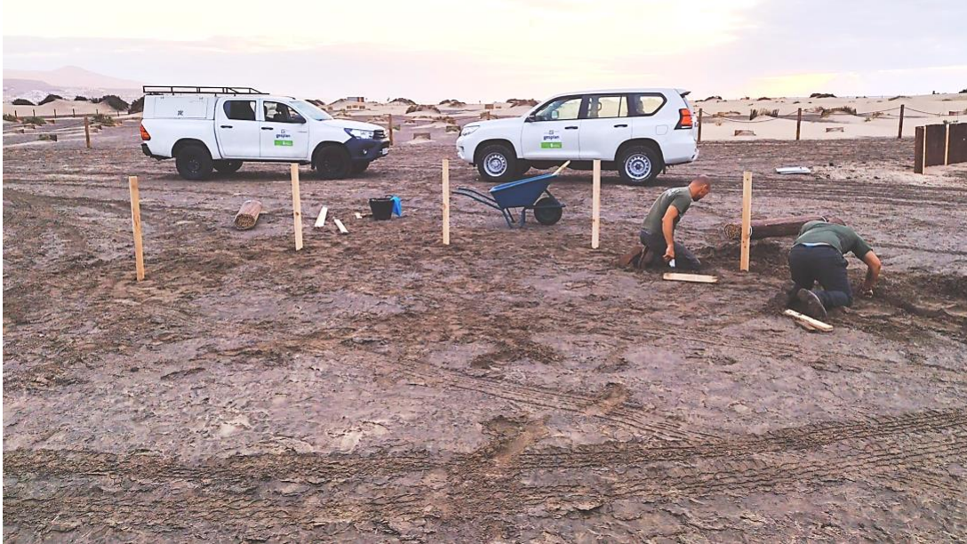
Imagen nº 7: Realización de la zanja para posteriormente introducir el mimbre. Fuente: Gesplan S.A.
