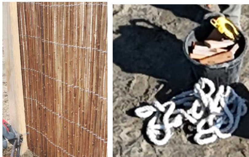
Imagen nº 2: Vistas de parte de los diferentes materiales empleados en la construcción de los captadores de arena. Fuente: Gesplan S.A.
