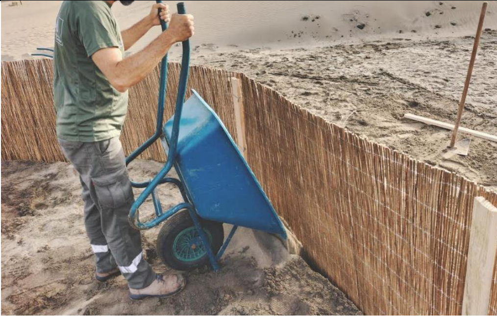
Imagen nº 11: Aporcado de arena para rellenar la zanja. Fuente: Gesplan S.L
